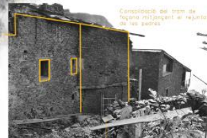
Neteja de la runa acumulada al llarg del temps
