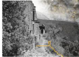
Adaptació del camí i col·locació de petites plaques per evitar el desplaçament de terres
